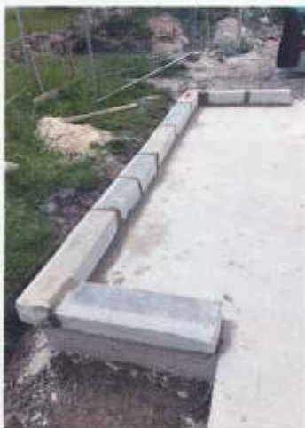
Mit der Errichtung der Sockelsteine für das Fachwerkgerüst wurde begonnen
