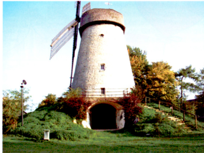
Die Windmühle vor dem Start der Sanierungsarbeiten
