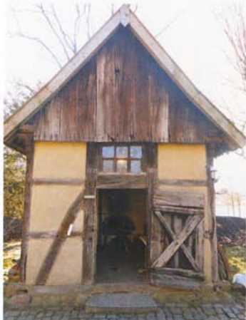
Auf dem Mühlenanger soll ein Backhaus entstehen
