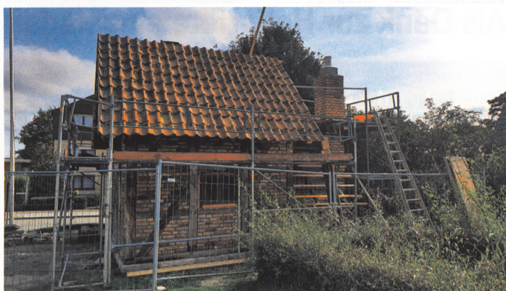
Wird ein Schmuckstück – das im Bau befindliche historische Backhaus
