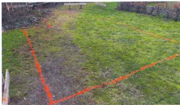
Der Grundriss des Backhauses ist nach der Absteckung schon zu erkennen
