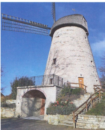
Die Windmühle präsentiert sich mit frisch saniertem Mauerwerk
